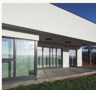
Passiivitalo. Asuinrakennus. Miño, Espanja. Aquarea.
